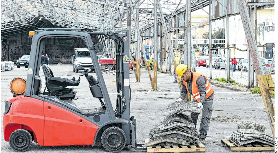
Umjesto stare krovne obloge od salonit ploča bit će postavljen novi limeni krov
